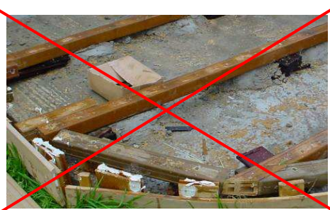
Rispettere una distanza di 10mm tra i travetti
