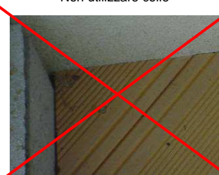
Prevedere una distanza di almeno 5mm tra le lame e 15mm tra le lame ed il muro oppure un ostacolo
